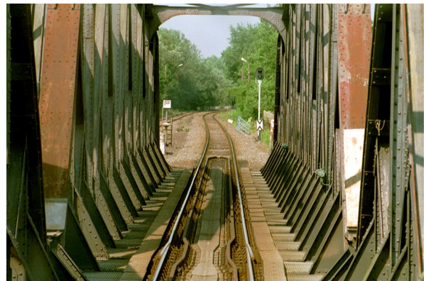
Detail der Oderbrücke mit Schienenauszug auf dem östlichen Überbau und Blick auf das Vorsignal für den Bf Kostrzyń
