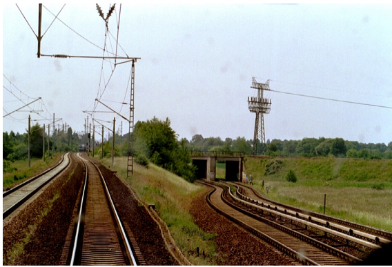
Teilweise im Bogen liegende Gleisverbindungen im Bf Berlin-Buch
