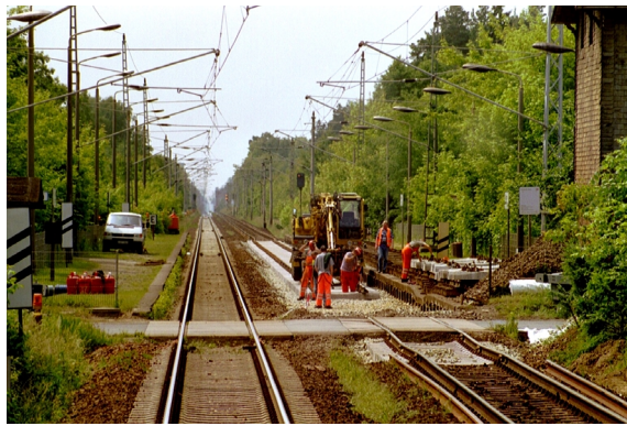
Erneuerung des Streckengleises Angermünde – Berlin am Hp Melchow
