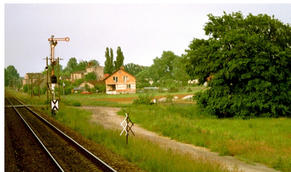
Typische Situation am Einfahrtssignal des Bf Bogdaniec aus Richtung Berlin – nicht technisch gesicherte Bahnübergänge
