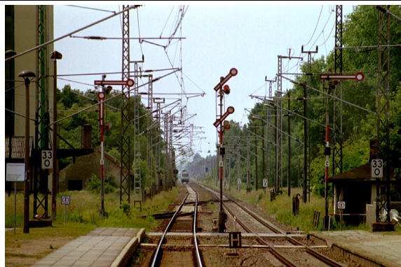
Bf Rüdnitz, Ausfahrt Richtung Berlin aus dem falschen Gleis. Im Bereich der Bahnhofsgleise liegt ein Bahnübergang, die Bahnsteige können nur mit einem Überweg erreicht werden.
