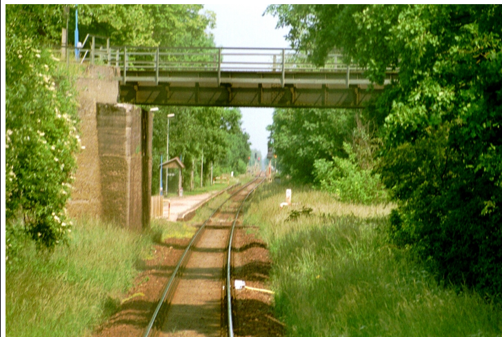
Eisenbahnüberführung der Strecke Frankfurt (Oder) – Angermünde am Hp Werbig km 67,17. Das Hauptsignal am Bahnsteigende ist das Einfahrsignal des Bf Werbig. Im Gleis in Höhe des Bahnsteiganfangs deutet eine Schlammstelle auf Schäden im Unterbau.
