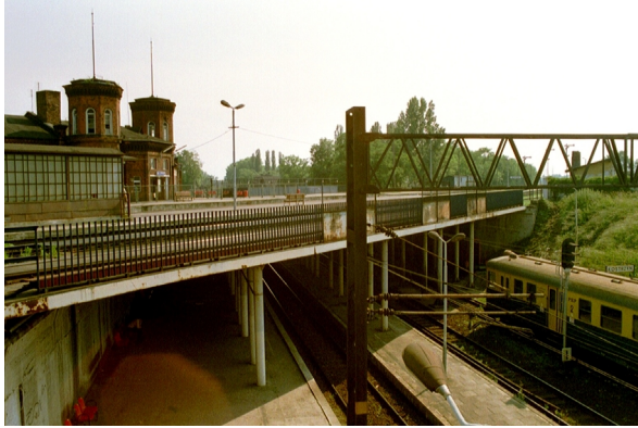
Kreuzungsbauwerk der Strecke Berlin (rechts) – Gorzow (links) über die Strecke aus Süden von Breslau nach Stettin
