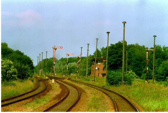
Die Sicht auf das Ausfahrtsignal im Bf Küstrin-Kietz Richtung Kostrzyń wird vom Wärter des Stellwerks wegen der Bogenlage der Gleise fernmündlich angekündigt.
