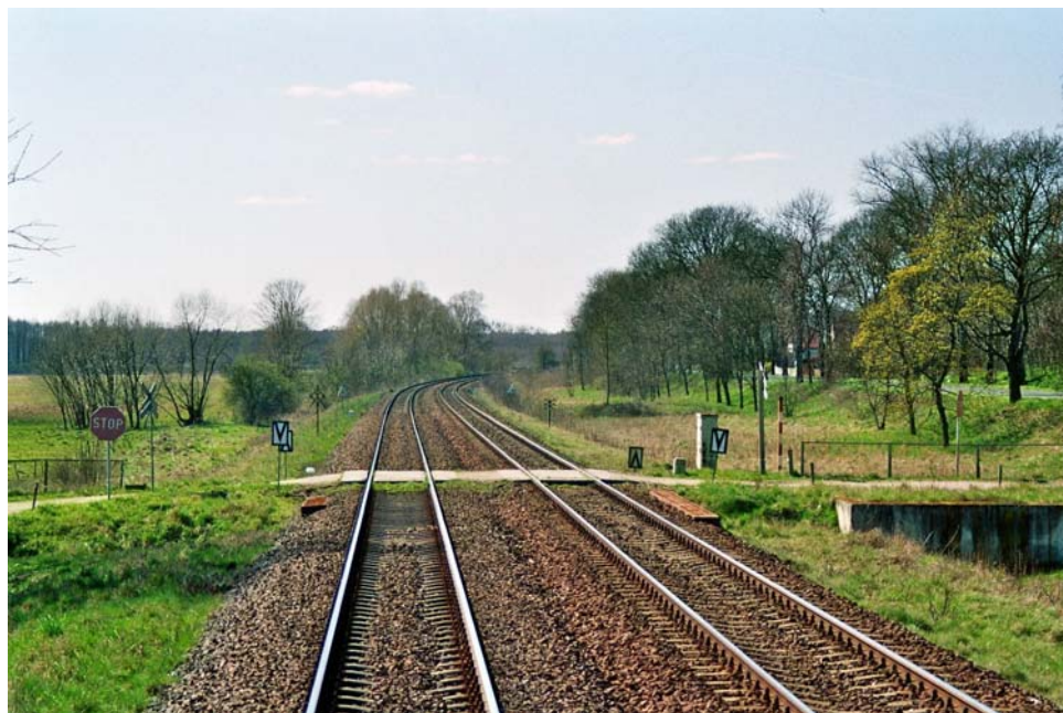
Abb. 16 Typische Situation der Bahnübergänge auf dem polnischen Streckenteil (freie Strecke): Ohne technische Sicherung und die Straßenfahrbahn ist in der Regel mit Stahlbetonplatten befestigt.
