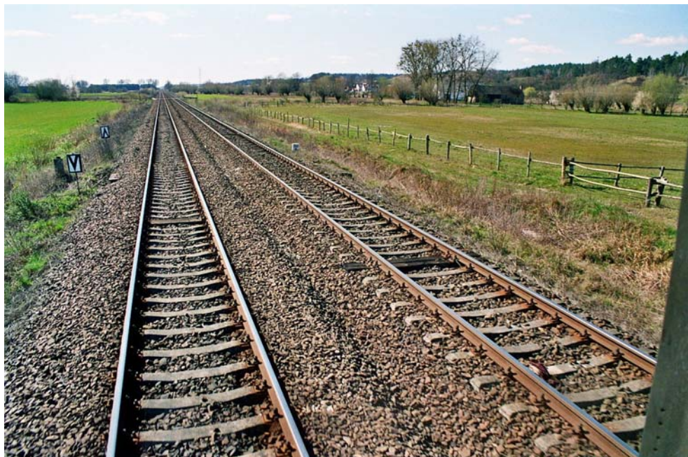
Abb. 24 Typische Oberbauanordnung für den polnischen Streckenteil - lückenloses Gleis auf Spannbetonschwellen mit K-Oberbau und hölzerne Kuppelschwellen an den vormaligen Schienenstößen.
