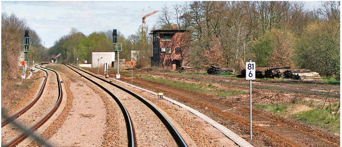
Abb. 8 Verbliebene Gleise des Bf Küstrin-Kietz mit dem Containergebäude des Elektronischen Stellwerks. Wie an anderen Stellen auch, bleiben stillgelegte Gebäude (wie rechts das Wärterstellwerk) weiterhin stehen.
