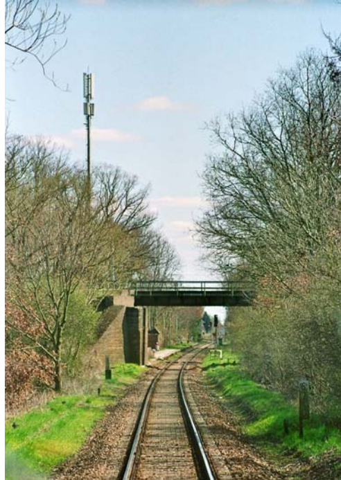
Abb. 5 Kreuzungsbauwerk mit der Eisenbahnstrecke Frankfurt (Oder) - Eberswalde und Mast für den Zugfunk, links der Bahnsteig des Bf Werbig, dessen Gleisanlagen nach dem Einfahrtsignal folgen.
