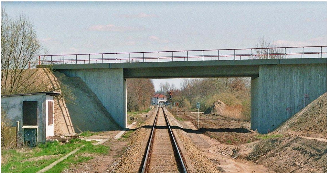
Abb. 6 Die Überführung der neuen Ortsumfahrung von Küstrin-Kietz im Zuge der Bundesstrasse 1 lässt jederzeit den Wiederaufbau des zweiten Streckengleises zu.
