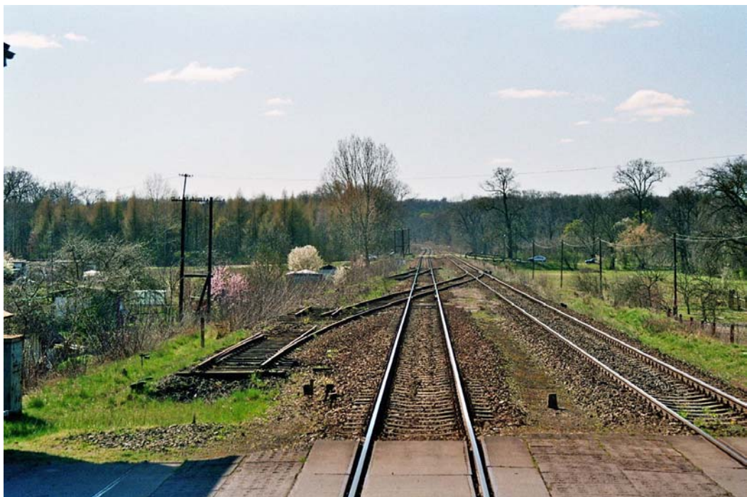
Abb. 18 Bahnhof Dąbroszyn. Das Überholgleis (links) ist stillgelegt und teilweise abgebaut, aber noch liegen die Weichen in den durchgehenden Hauptgleisen.
