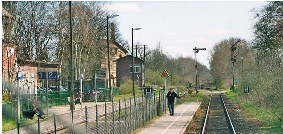
Abb. 2 Der Zwischenbahnsteig des Bf Rehfelde wird im Zuge des vorgesehenen Bahnhofsumbaus im Jahre 2008 gegen einen Neubau als Außenbahnsteig ersetzt werden.
