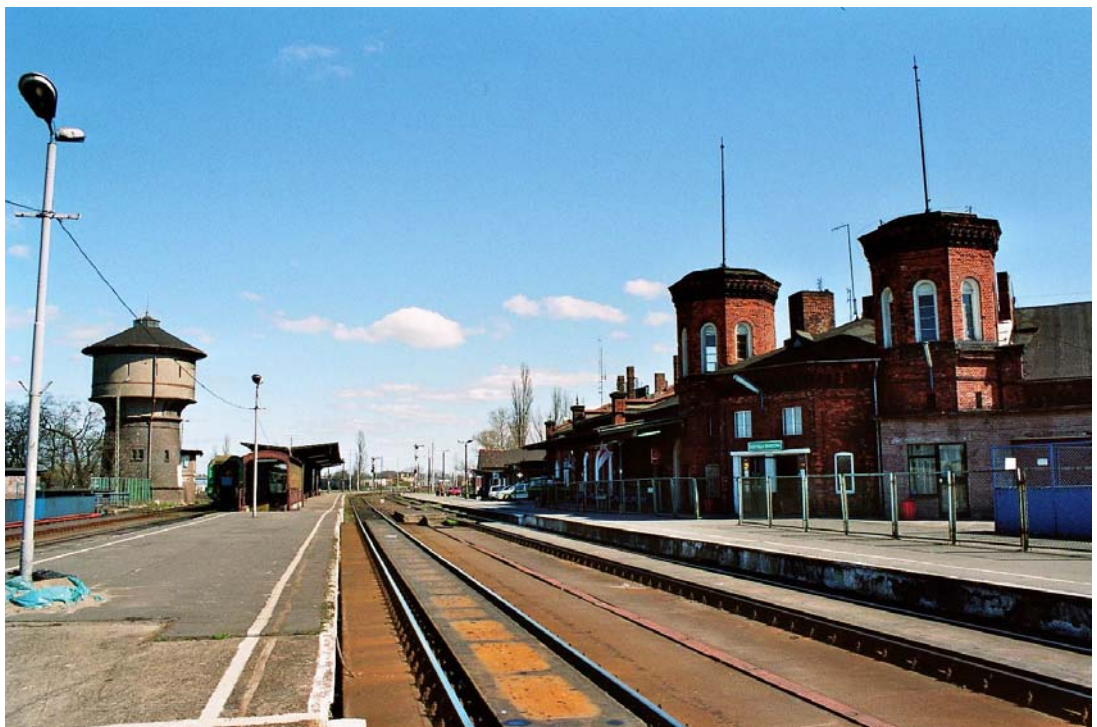
Abb. 12 Gleisanlagen der Ostbahn im Bf Kostrzyn mit dem Empfangsgebäude und Hausbahnsteig 1 ( rechts ) und dem Inselbahnsteig 2/3 ( links ). Die Bahnsteige sind durch einen Personentunnel verbunden, über den zugleich die Bahnsteige an den tiefliegenden Gleisen der Strecke Rzepin - Szczecin erreicht werden.
