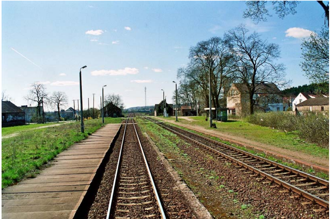
Abb. 23 Haltepunkt Łupowo. Der ehemalige Zwischenbahnsteig ist stillgelegt und durch einen Außenbahnsteig aus Betonfertigteilplatten ersetzt.
